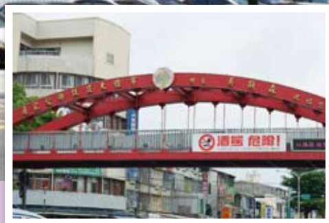
封面 | 大雅衛生所
